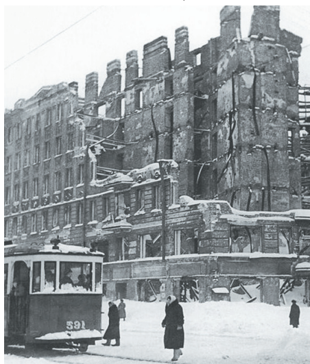
Разрушенное во время бомбежки здание
