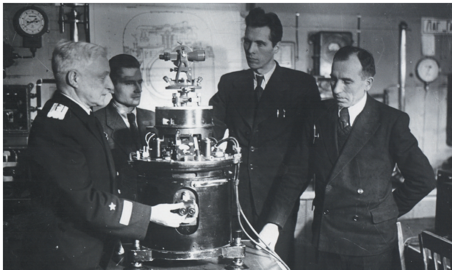
Испытание маркшейдерского гироскопического компаса М-1 сотрудниками кафедры (слева направо): К.С. Ухов, А.А. Зметенкевич, И.В. Иванов и П.А. Ильин. Фото 1950 года
